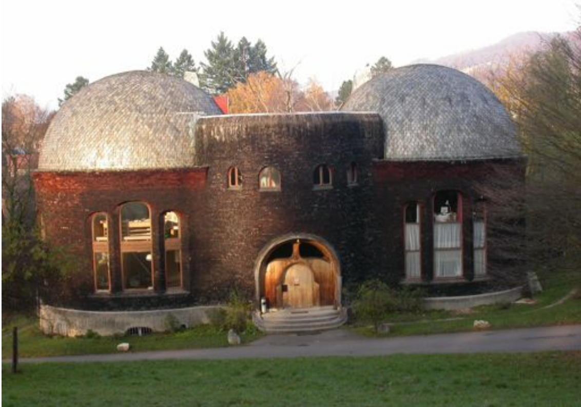
Das Glashaus 2004 vor der Renovation
